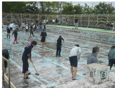
☆肌寒い中の作業。丁寧に汚れ落とし
